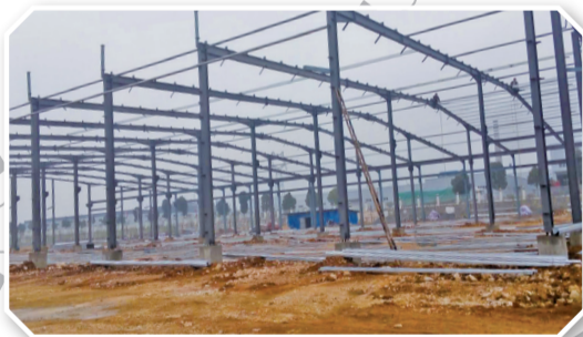
贵州厚诚产业扶贫厂房进展。
