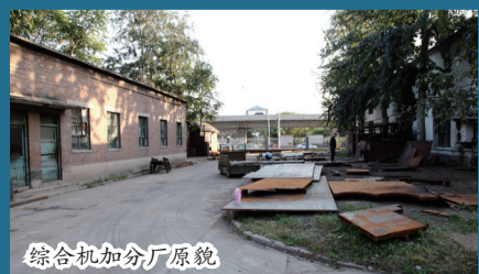
综合机加分厂原貌
